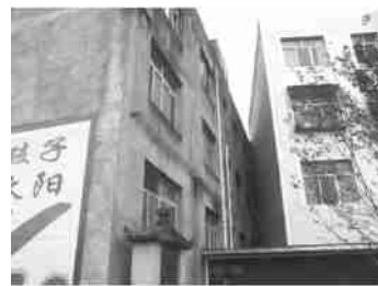
图10 建筑物间没有防震缝宽度
