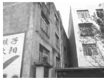
图10 建筑物间没有防震缝宽度
