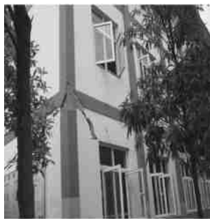
图 12 位于结构端部 构造柱剪切破坏 (都江堰青城中学)
