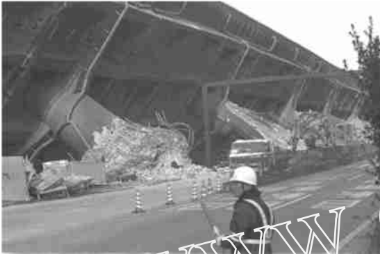
图1 桥墩塑性铰破坏
