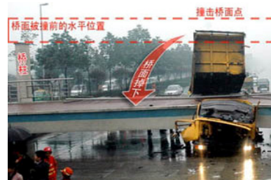
图 17 人行天桥落梁照片
