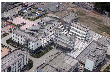
图 1 漩口中学建筑震害示意图(网络照片)
