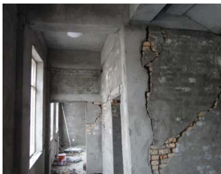
照片 20 州农发行填充墙严重开裂
