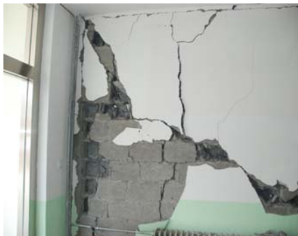
照片 20 州农发行填充墙严重开裂
