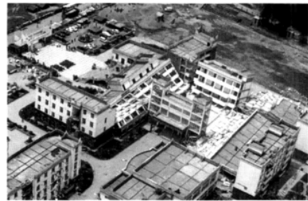
图 1 漩口中学建筑震害
